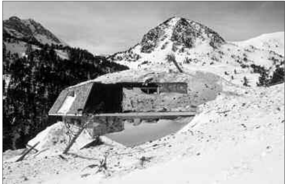
Allau de neu recent que afecta bosc i edificacions (projecte ALUDEX).
