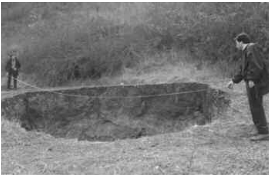
Colapse en un àrea de la zona potàssica.
