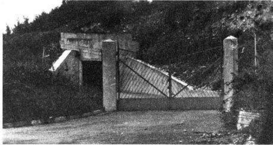
Az AFFI-i háborús vezetési pont bejárata
