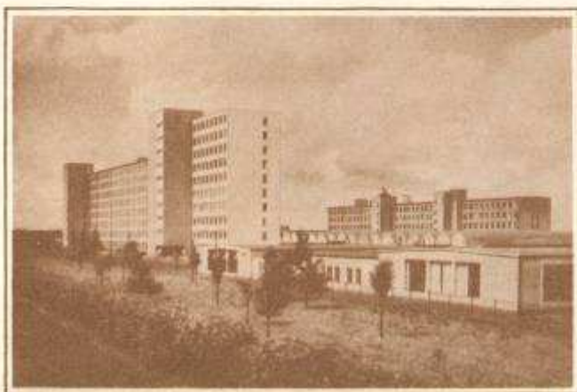
38. Méréstechnikai üzemsz (Siemens) E—3
