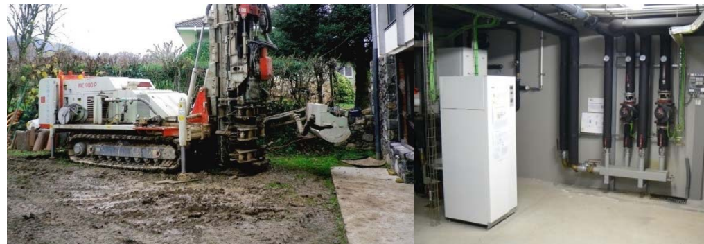
Perforació de sondatge per a la implementació d'un camp de captació geotèrmic / instal·lació bomba de calor geotèrmica
