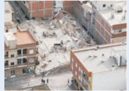
Únic edifici que va col·lapsar durant el terratrèmol
