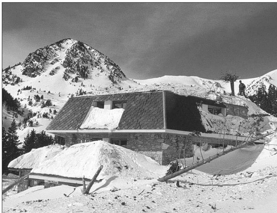
Figura 50. L'allau va arrencar gran quantitat d'arbres i el dipòsit va arribar fins a la teulada de l'edifici (Ripollès). (foto: ICC)
