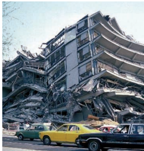
Imatges de danys en un edifici. Font: Servei Geològic dels Estats Units (USGS).
