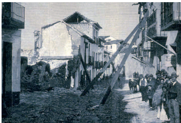
Detall de les destrosses produïdes pel terratrèmol de Nadal de 1884 al poble de Velez-Málaga. A l'època la fotografia encara no era gaire comuna i es tracta d'un apunt pres uns dies després, quan ja s'han apuntalat algunes façanes. Font: IGN.
