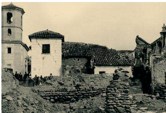
Destrosses produïdes pel terratrèmol de Nadal de 1884 al poble de Murchas. Noteu la campana caiguda a la base de la finestra del campanar. Font: IGN.
