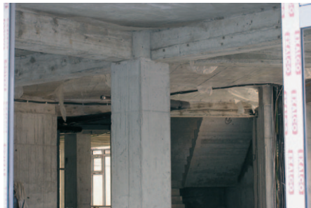
Edifici amb bigues de cantell.
