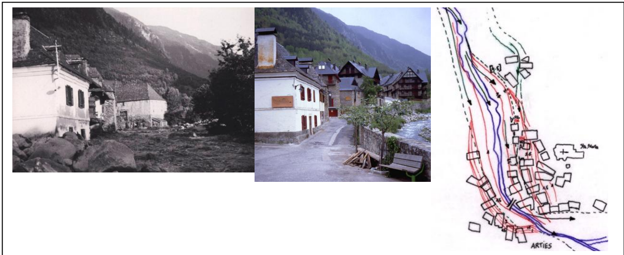
Figura 8 – a) izquierda: foto tras el paso de la crecida del río Valarties en Arties (Vall d'Aran) en 1963; véase la altura del cauce aluvial y la magnitud de los depósitos; b) centro: foto del mismo lugar en 2002 (9) véase el nuevo cauce ¿de agua clara?; c) derecha: mapa de isolíneas del depósito dejado por la avenida torrencial (gentileza TYPESA).
