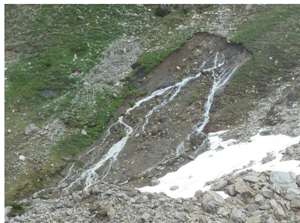
Figura 6 – Cicatriu d'esllavissada en materials col·luvials on s'observen surgències (IGC, 20/06/2013).
