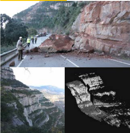
Monitoreig amb imatges LIDAR d'una zona susceptible de caiguda de blocs
