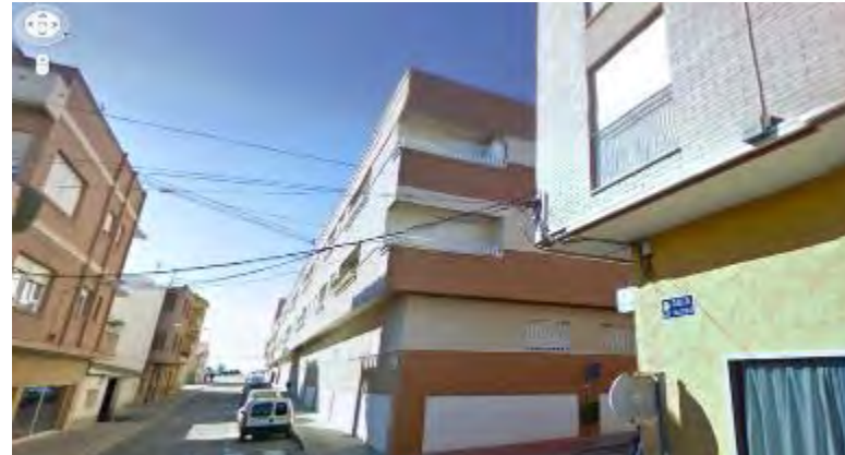
Edifici nou de 3 plantes - La Viña, Llorca
