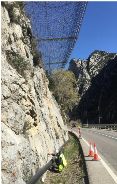
Execució de treballs geofísics al Túnel dels Tres Ponts.
