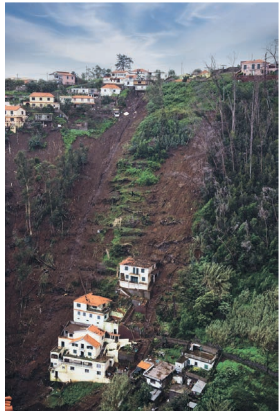
Figura 1.20. Afectació a edificacions per les esllavissades. Extreta de ©Nelson d'Aires/2010.
