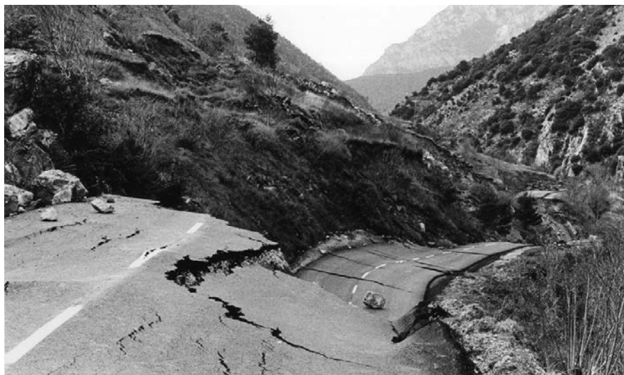
Figura 2.41. Desperfectes a la carretera C-1313 com a conseqüència de l'esllavissada del Pont de Bar. Autor desconegut.
