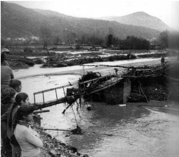
Figura 2.26. Estat del Pont de la Palanca dels Gitanos, a la Seu, després dels aiguats de novembre de 1982. Font: Arxiu Vilarrubla. Autor: Josep Xicota.
