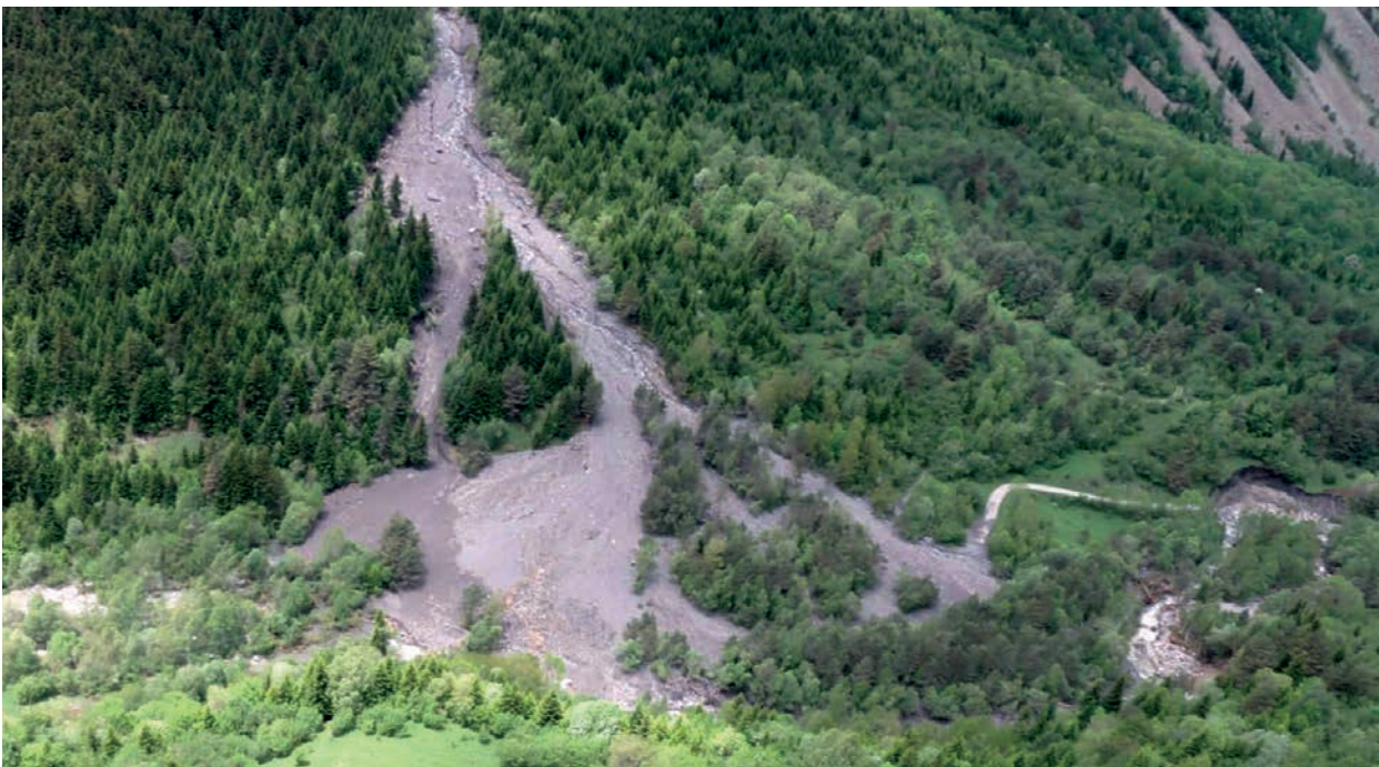
Figura 2.56. Imagen de helicóptero de la acumulación de material en la parte más distal de cono de deyección del barranco dera Aubeta, que afectó a la carretera de Valarties y el Pont deth Ressèc. Fuente: IGC (2013), AP-049/13.
