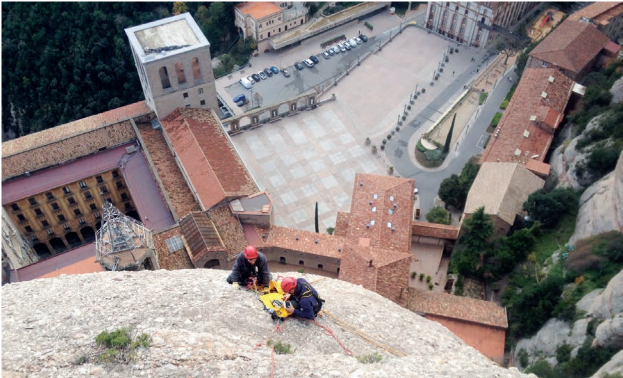
Figura 4.4. Treballs d'instal·lació de sensors de la Xarxa d'auscultació geotècnica. Pla de mitigació del risc a Montserrat. Font: ICGC.
