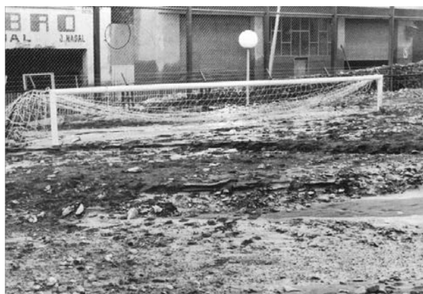
Figura 2.24. Detalle de la portería del campo de fútbol de Aixovall que permite estimar el grueso aproximado de los depósitos (agua y sedimentos) en unos dos metros, provenientes de la subcuenca del río de Ôs de Civís y sus afluentes (Setúria y Salòria). Fuente: Expansión – ANDORRA, noviembre de 1982.
