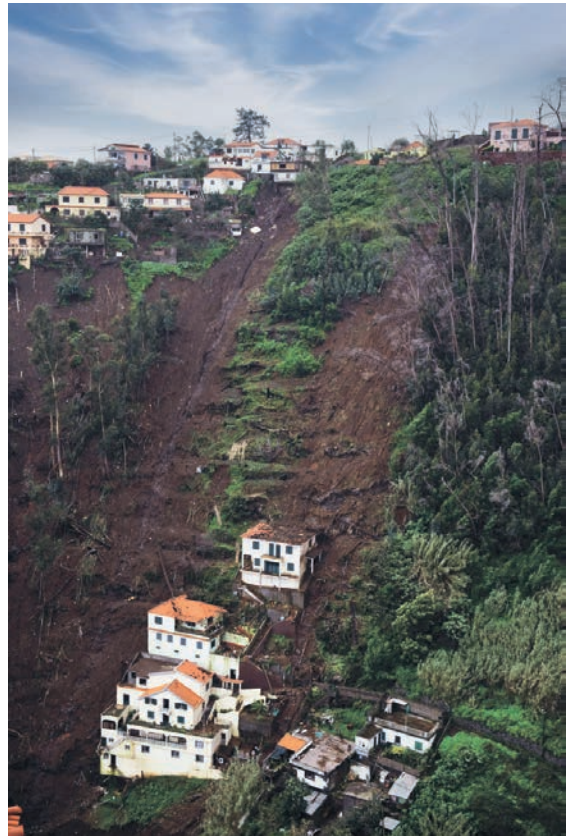
Figura 1.20. Afectación a edificaciones por los movimientos de ladera. Extraída de ©Nelson d'Aires/2010.
