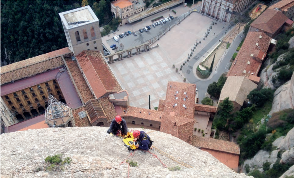
Figura 4.4. Trabajos de instalación de sensores de la red de auscultación geotécnica. Plan de mitigación del riesgo en Montserrat. Fuente: ICGC.
